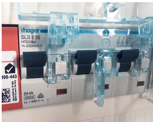
Der SH-Schalter schützt Ihre Anlage vor einem Kurzschluss
